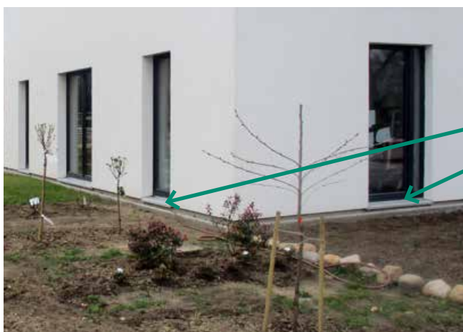
Sohlbänke an einem Neubau.
